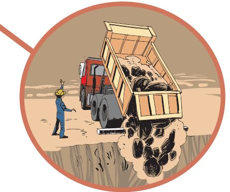
Para la descarga hay que poner topes y las señales deben ser perfectamente visibles para el conductor
